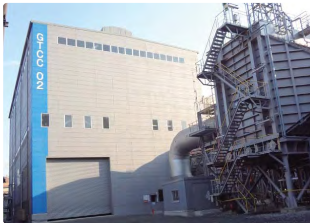
▲ 新たに運転を開始した2基目のGTCC(外観写真)
