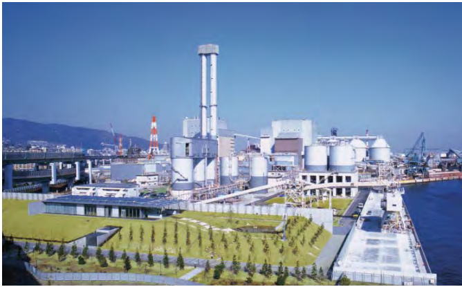
神鋼神戸発電所
