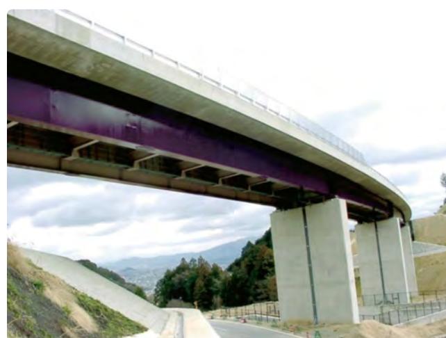
▲ 代表的採用事例:奈良県南阪奈道路 當麻第二橋(鋼上工)
