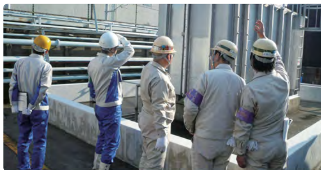
▲ 防災確認調査(神鋼メタルプロダクツ(株))
