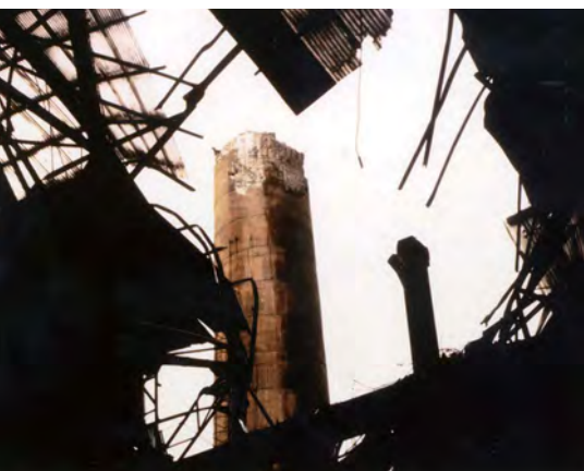
倒壊した神戸製鉄所・第7線材工場
