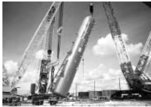
写真 2 2.25Cr-1Mo-V 改良鋼製リアクタ Photo 2 2.25Cr-1Mo-V modified steel reactor
