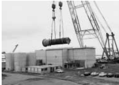
写真 3 播磨大型リアクタ組立工場 (max 2200ton) Photo 3 HARIMA final assembling shop (max 2200ton)
