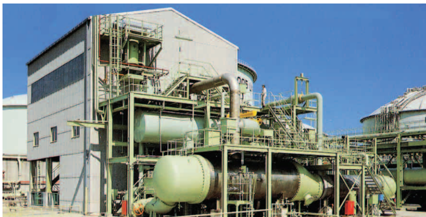
図6 6,000kW 冷熱発電設備外観写真(大阪ガス株式会社泉北製造所第二工場)
