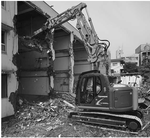
図15 SK135SRDLC セパレートブーム仕様機 Fig.15 SK135SRDLC separate boom attachment machine
