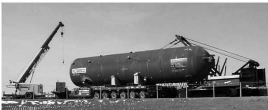
図2 カナダ現地でのリアクタ上部の移動 Fig. 2 Transportation of top half of reactor at Canadian site
