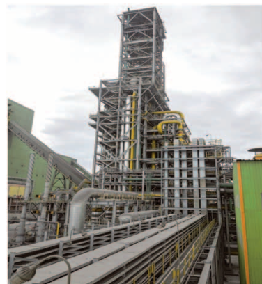
図5 アルジェリア・オランのトシアリ社の製鉄所に建設された最新MIDREX NGプラント(還元シャフト炉(奥中央)と製鋼工場(奥左側)にHDRIを搬送するコンベア(手前)) Fig.5 Latest MIDREX NG plant: Tosiya in Oran, Algeria. (Reduction furnace in center with HDRI conveyor to EAF meltshop on left side.)
