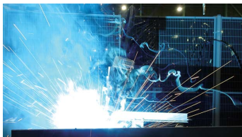
通常の炭酸ガスアーク溶接
