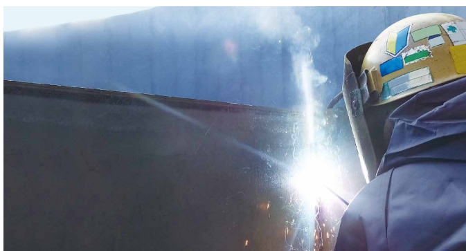
原油タンクの補修溶接 (FAMILIARC™ B-14 使用)
